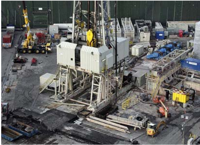
Le projet de géothermie bâloise bat de l'aile. [Keystone]
