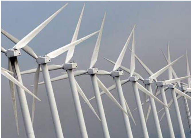
Les dix nouvelles éoliennes alimenteront en énergie près de 10'000 ménages vaudois. [Reuters]
